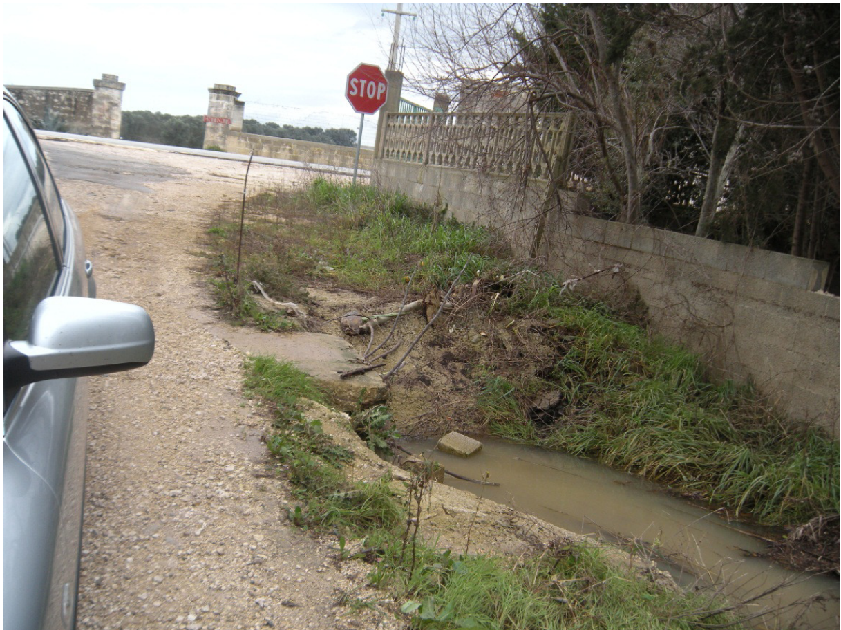
B1 – Punto di interrimento e curvatura del canale nei pressi della SS. 605
