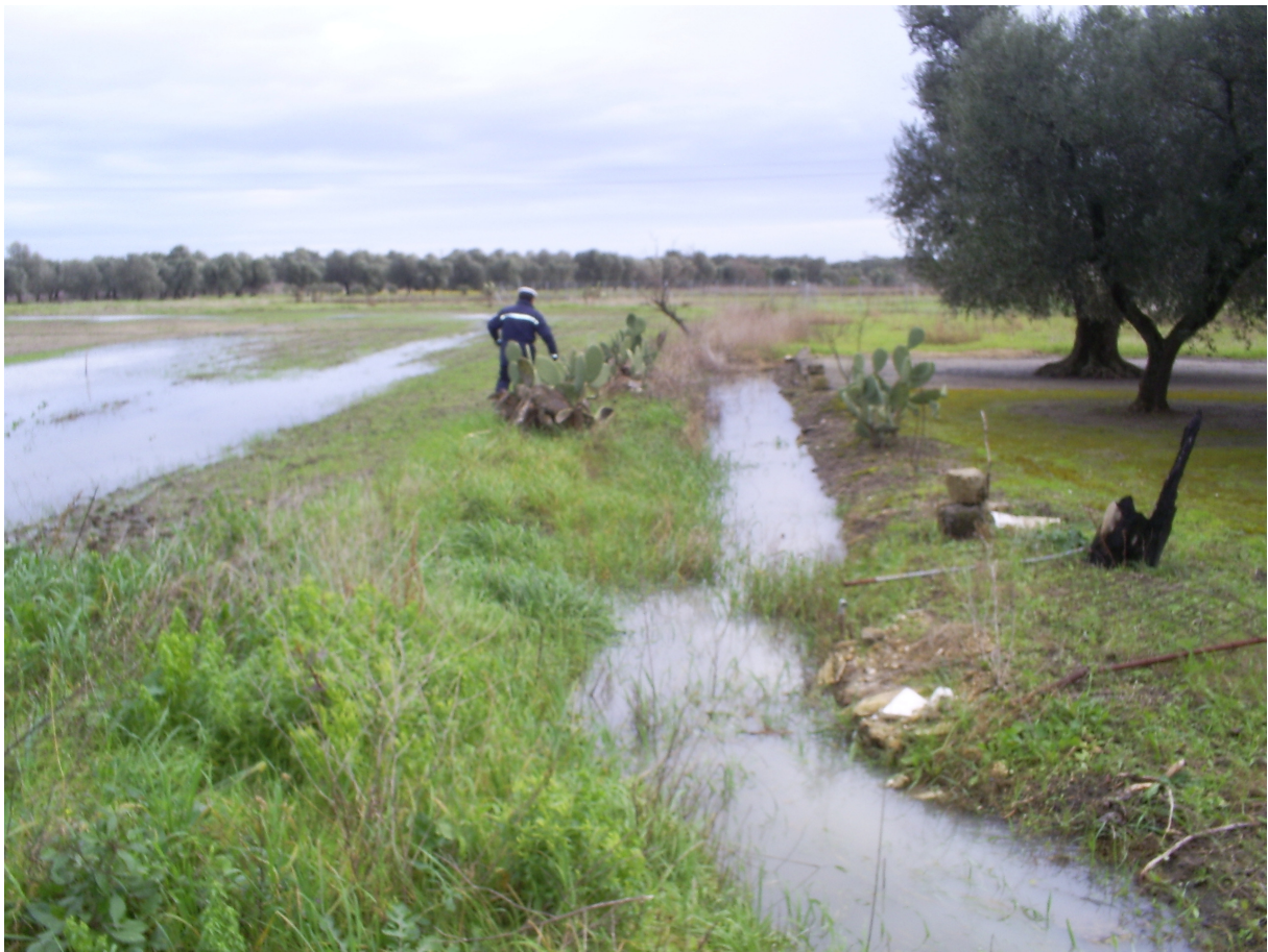
D1 – Particolare del canale con i terreni allagati
