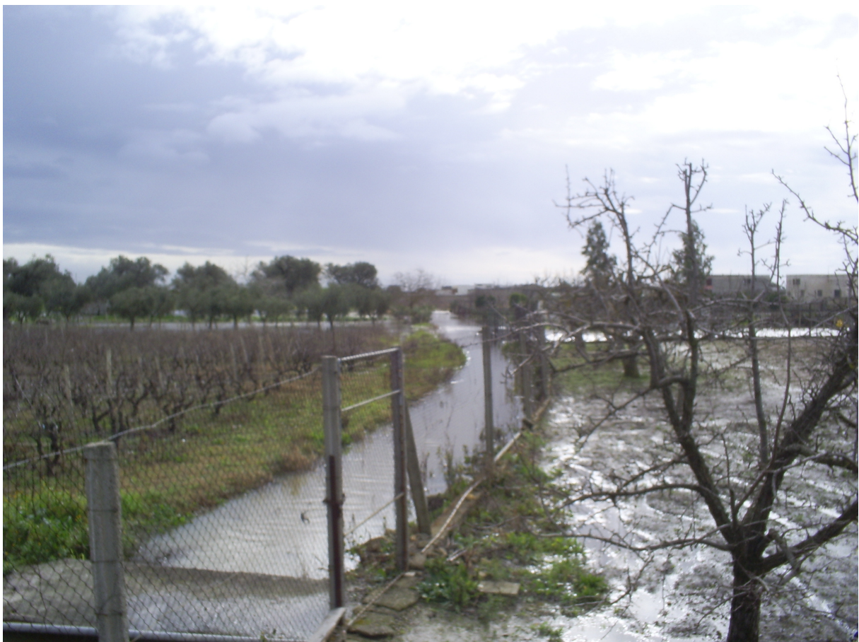
D2 – Particolare del canale con i terreni allagati
