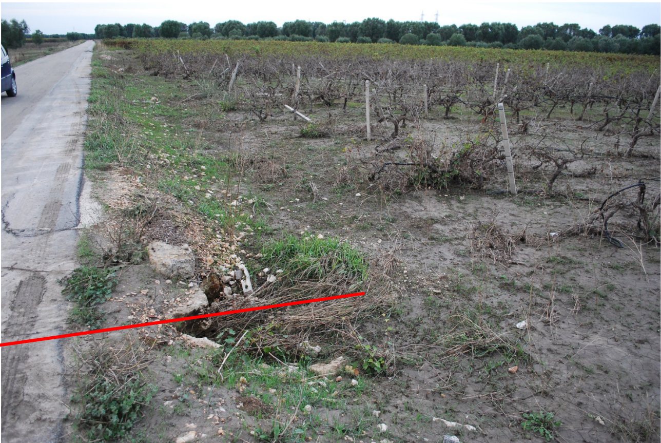
Attraversamento 3 lato dx
